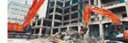
旧岡島百貨店様の解体工事
